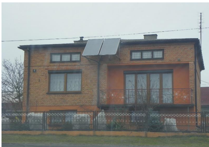
Fig. 3.5. Panele solarne na jednym z domów w Chorzęcinie (6.03.2015 r. fot. Ł. Lelek.)
